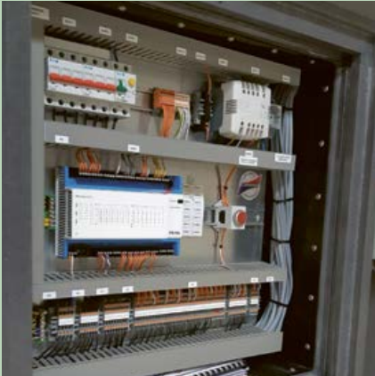
Afbeelding 5.5 Geïntegreerde regeling luchtbehandeling
